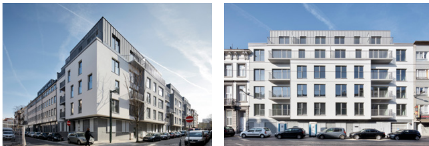
© Fonds du Logement
