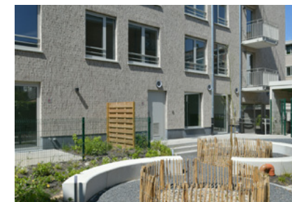
© Fonds du Logement
