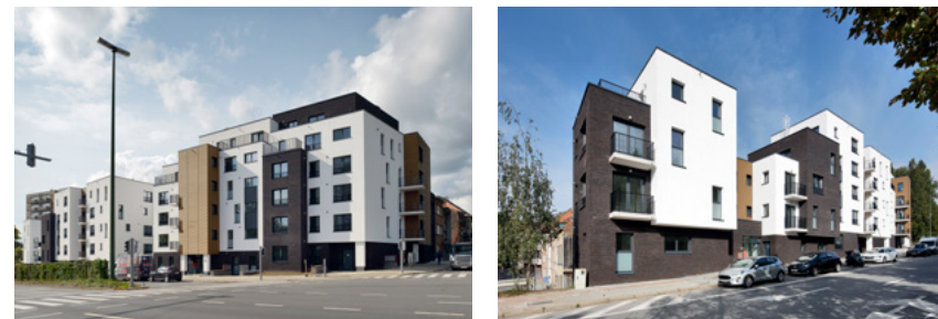
© Fonds du Logement
