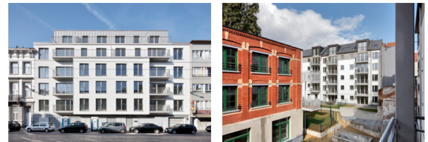
© Fonds du Logement
