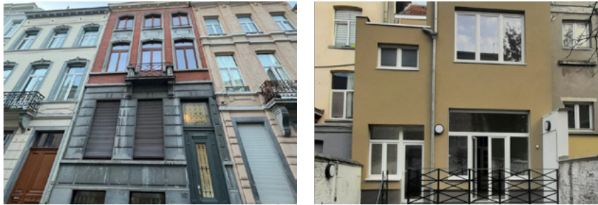
© Fonds du Logement
